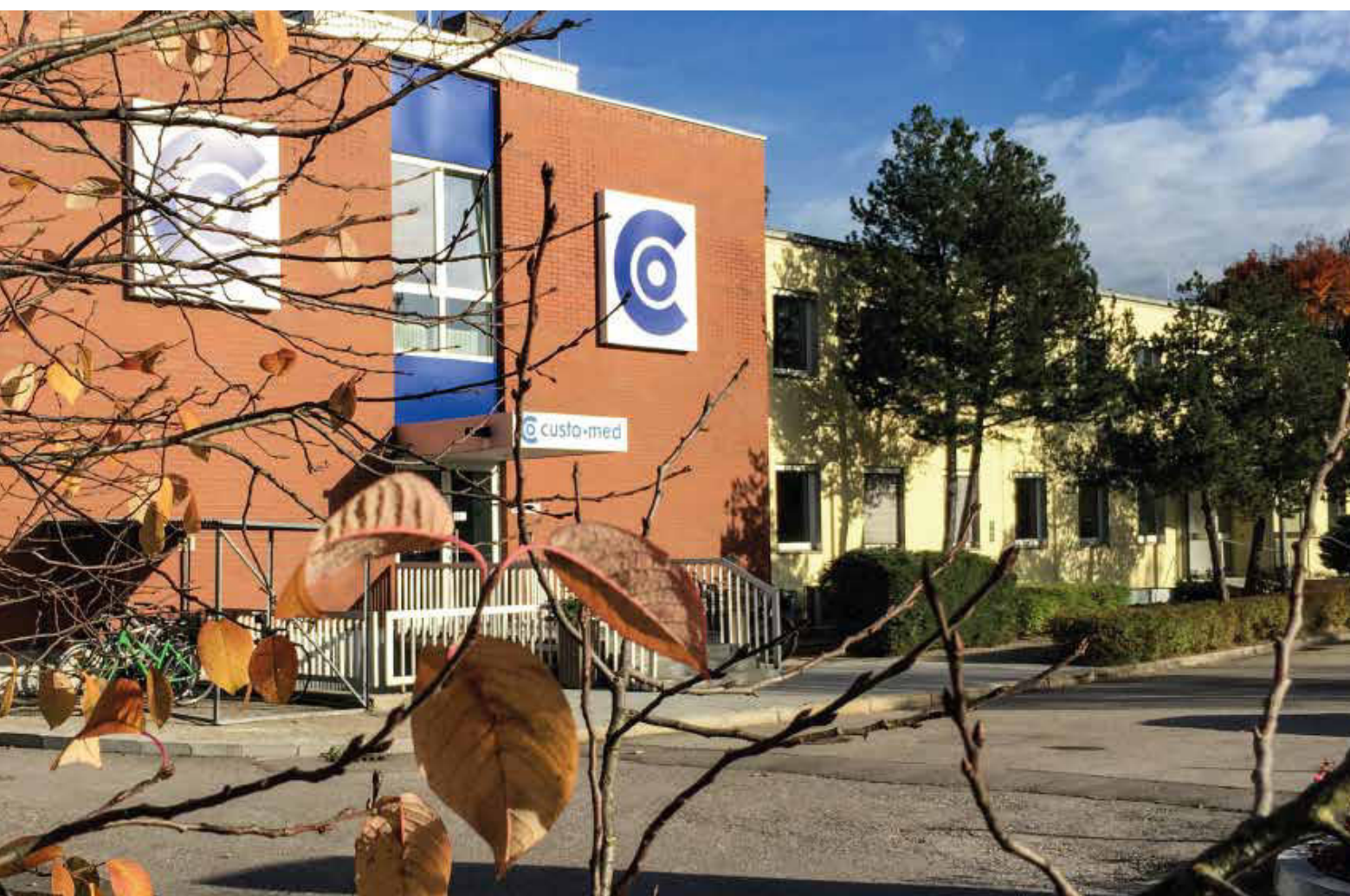
Instalaciones de custo med GmbH en Ottobrun - Alemania
